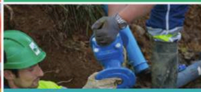
Travaux sur réseau
